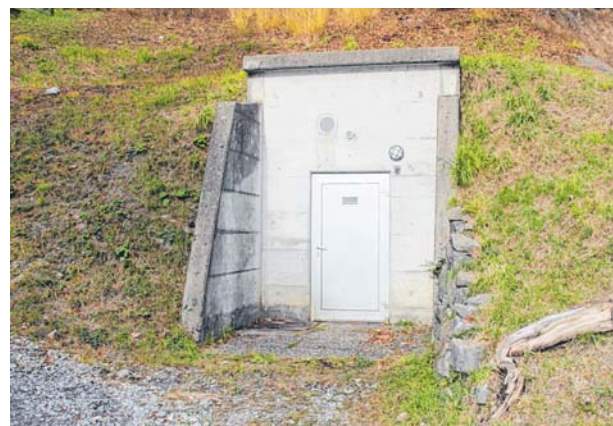
Der alte Hochbehälter wird saniert.
