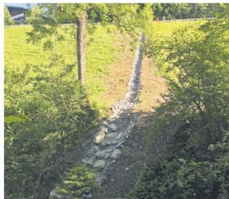
Die Oberflächenwässer werden oberhalb des Siedlungsraums gesammelt und direkt in den Ratzbach weitergeleitet.
